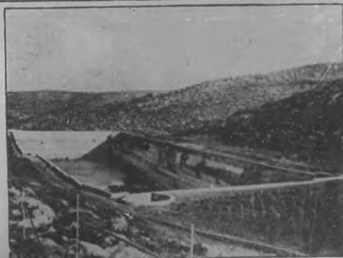
La famosa alberca de Salomón, que reparada por los ingleses, se está utilizando de nuevo para contribuir a remediar la escasez de agua en Jerusalén. Dicha alberca fue construida en tiempos de Poncio Pilato.
